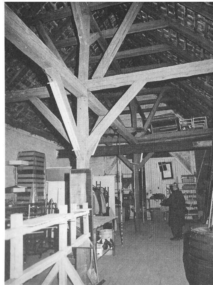
Fig. 21. Foderloft i magasinlængen i baggården (h på grundplanen fig. 18). Der er højt til loftet! Bygningen er fra omkr. 1840. (Fot. Fl. Rasmussen 1986).
