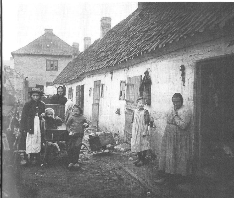
Fig. 16. Her er bagsiden. – Ved Bredgade havde købmanden opført denne lange »lejevaaning« på gårdens grund, (se l på fig. 18). Nok var der rige folk i Roskilde, men mange, mange flere boede sådan. Bygningen blev revet ned mellem 1900 og 1908, og på grunden opførtes Børneasylet i 1908. (Fot. Kr. Hude omkr. 1900, RLA).
