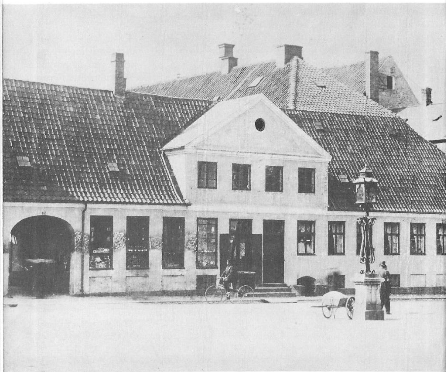
Fig. 15. Her er forsiden. – Ud mod torvet lå det 33 m lange forhus. Det fik omkring 1837 denne statelige facade i grundmur, men i 1891 blev det ombygget, så facaden kom til at se ud som på billedet fig. 26. (Fotografiet her er taget omkring 1890 og findes i den Ældre fotosamling på RM).
