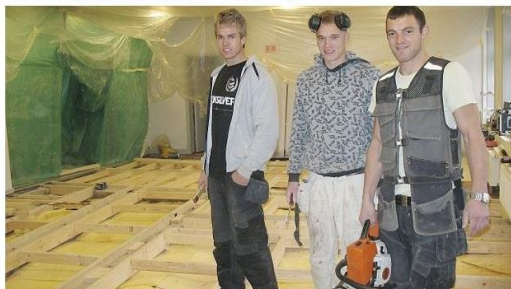
Gulvet var så skævt, at vatterpasset rutsjede. Det kunne de tre tømrere på billedet heldigvis rette op på. Her er de fotografert godt midtvejs i deres arbejde, før de egentlige gulvplader skulle på. Fra venstre ses Henrik Kristensen, Benjamin Christensen og til højre Jonathan Irving.
